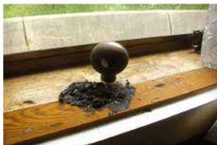
出火箇所の出窓台上の状況
