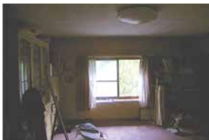
2階の出火室の状況
