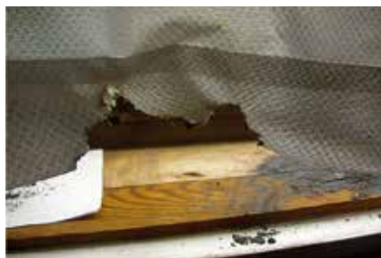
一部焼損した防災カーテン
