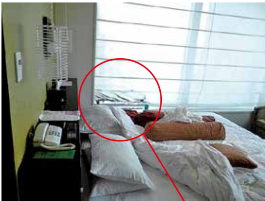
火災発生場所の客室内
