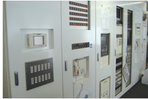
防災センター
