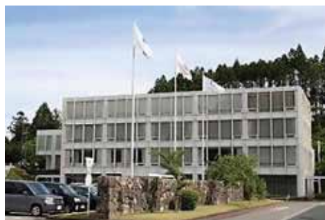
本社・市原事業所本館 外観
