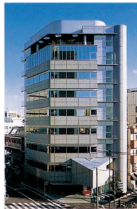
本社ビル 外観
