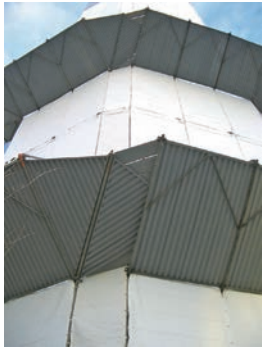
PE防災シート使用例
