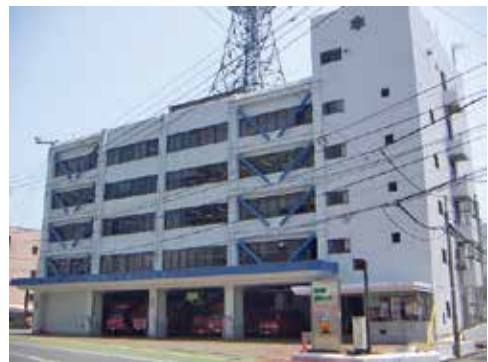
消防局・中央消防署庁舎
