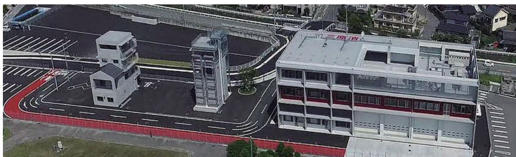
三原市消防本部(平成29年新築移転)
