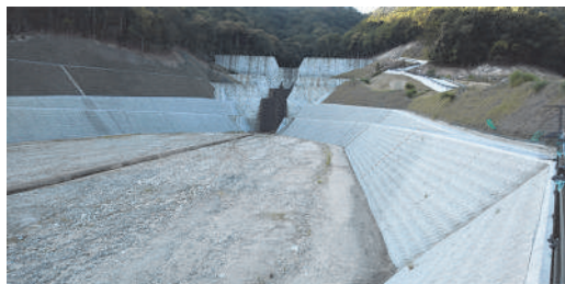
写真1：災害後に整備された砂防施設（広島市安佐南区）
