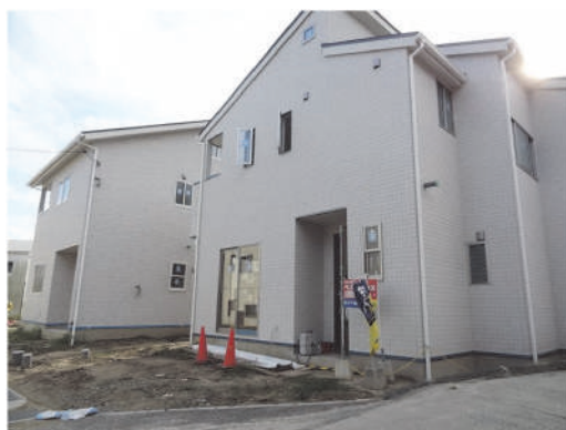
写真2：土砂災害の被災地域に建てられた住宅
