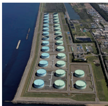
福井国家石油備蓄基地
